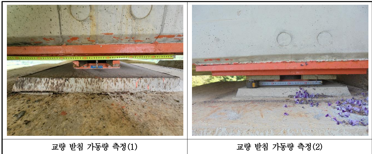
【사진 12.3.41】 교량받침 이동량 측정
