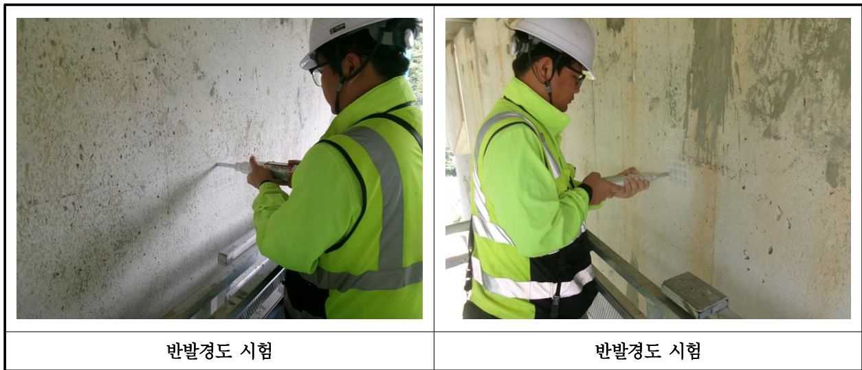
【사진 12.4.2】 반발경도시험 현장사진
