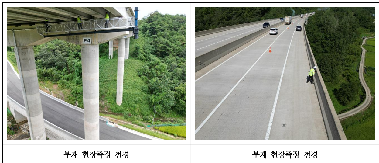
【사진 12.2.1】 부재 현장측정 전경
