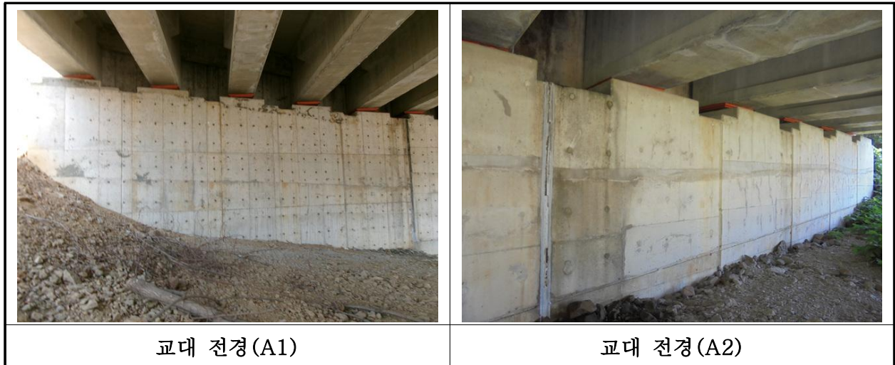
【사진 12.3.33】 교대 전경
