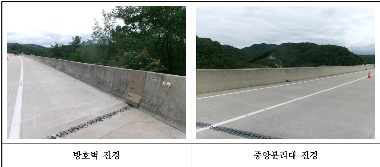
【사진 12.3.49】 방호벽 및 중앙분리대 전경
