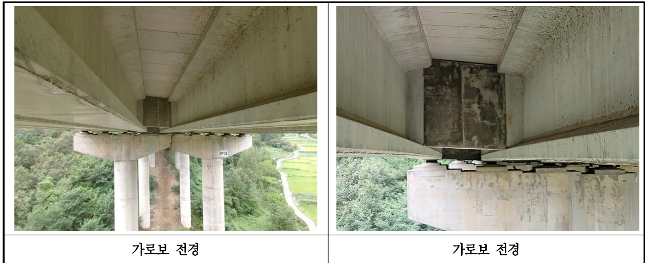
【사진 12.3.31】 가로보 전경
