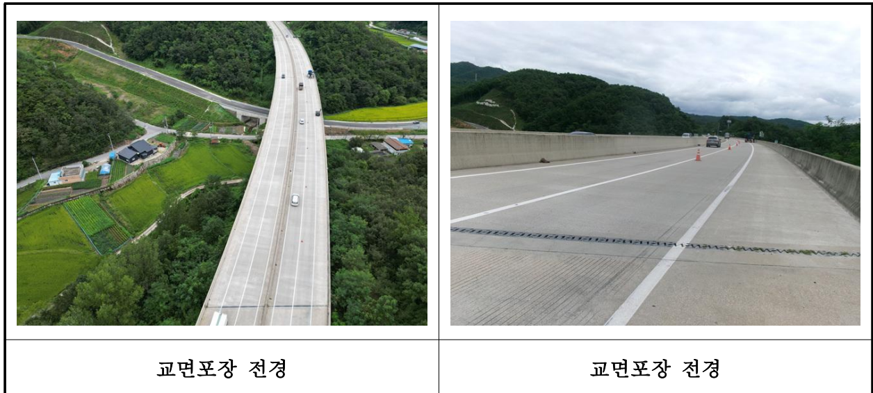
【사진 12.3.45】 교면포장 전경
