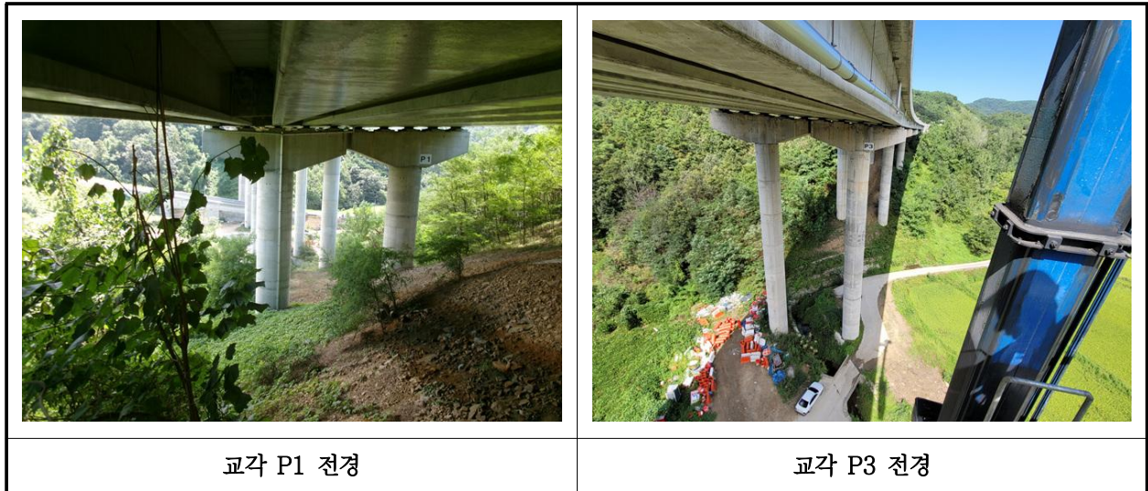
【사진 12.3.10】 교각 전경
