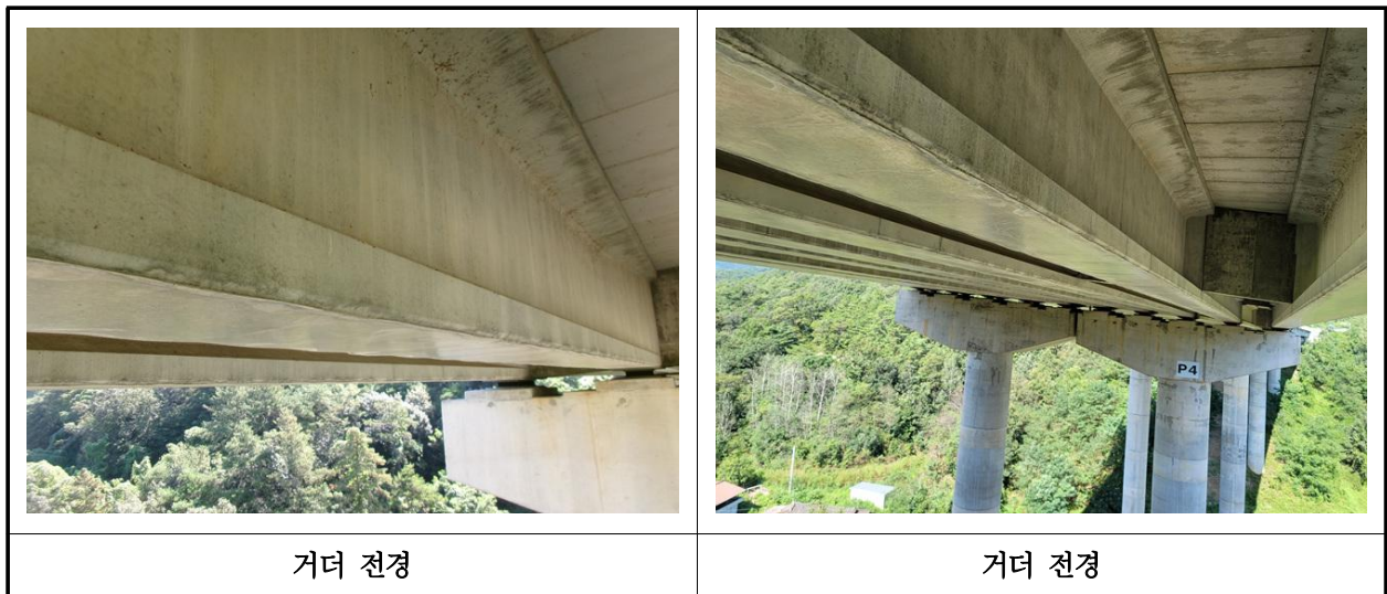
【사진 12.3.4】 거더 전경
