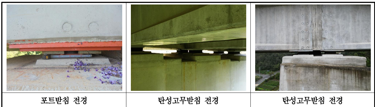
【사진 12.3.38】 교량받침 전경
