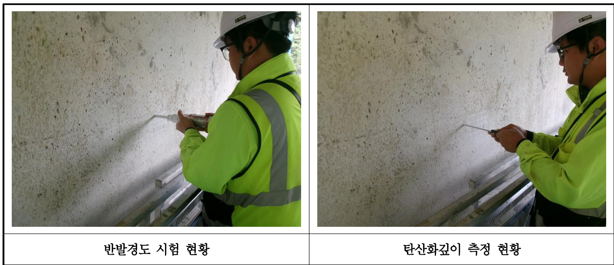
【사진 12.4.1】 콘크리트 내구성조사 현황
