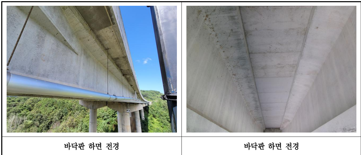
【사진 12.3.2】 바닥판하면 전경
