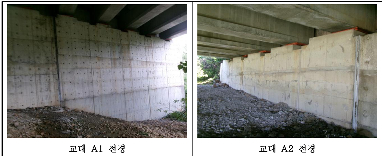
【사진 12.3.8】 교대 전경
