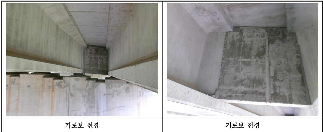
【사진 12.3.6】 가로보 전경
