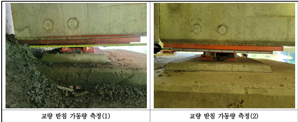
【사진 12.3.16】 교량받침 이동량 측정
