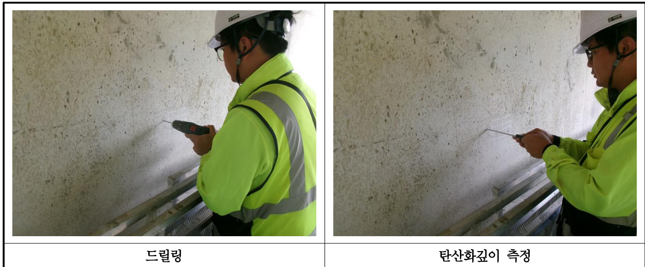
【사진 12.4.3】 탄산화 깊이 측정 현장사진
