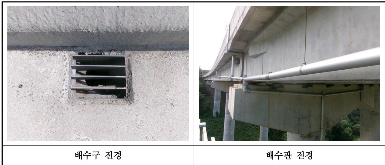
【사진 12.3.22】 배수시설 전경
