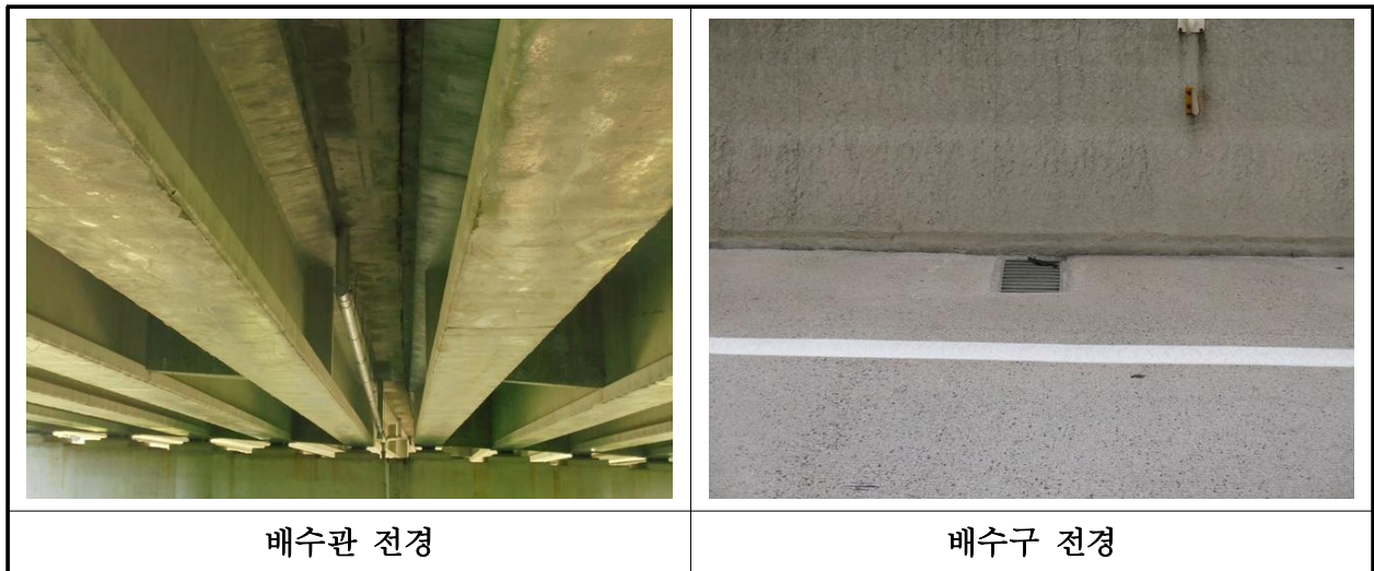
【사진 12.3.47】 배수시설 전경
