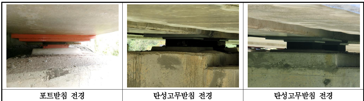
【사진 12.3.13】 교량받침 전경
